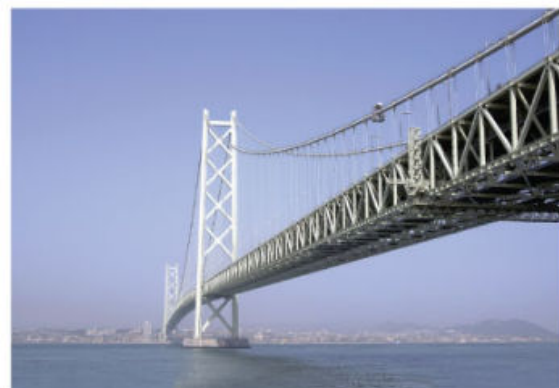
Figura 2.34 El puente del estrecho de Akashi en Japón, es el más largo del mundo, tiene una longitud total de casi cuatro kilómetros. Los cables que soportan el peso de la estructura (casi 160,000 toneladas) y las oscilaciones del puente debido a los fuertes vientos y terremotos están hechos de miles de alambres de acero. Si los metales no tuvieran las propiedades de maleabilidad y ductilidad sería imposible pensar en construir estas enormes estructuras.
