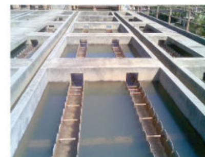
Figura 1.16 Procesos de sedimentación y flotación en una planta de tratamiento de agua.
